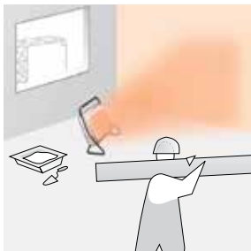
Secado de pared en obra.
